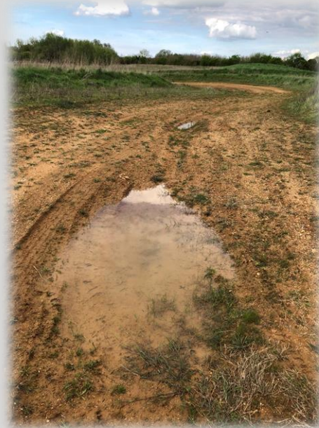
Photo 20 : Exemple d'ornière fonctionnelle laissée en l'état (haut) et à restaurer (en bas)
